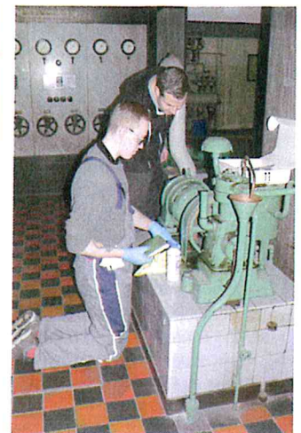
Auch um die Gebäudetechnik kümmerten sich die angehenden Fachkräfte.
